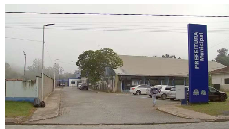
Prefeitura de Guapiara (SP) passou a utilizar como Paço Municipal o prédio que deveria abrigar o Caps — Foto: Jamie Rafael/TV TEM
